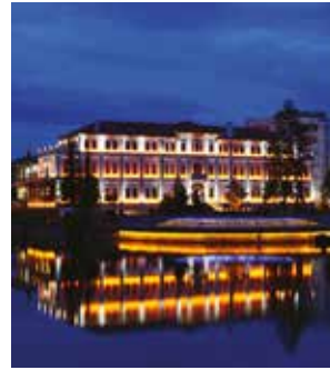
Dış Cephe Aydınlatma Exterior Lighting
