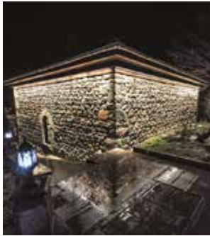
Dış Cephe Aydınlatma Exterior Lighting
